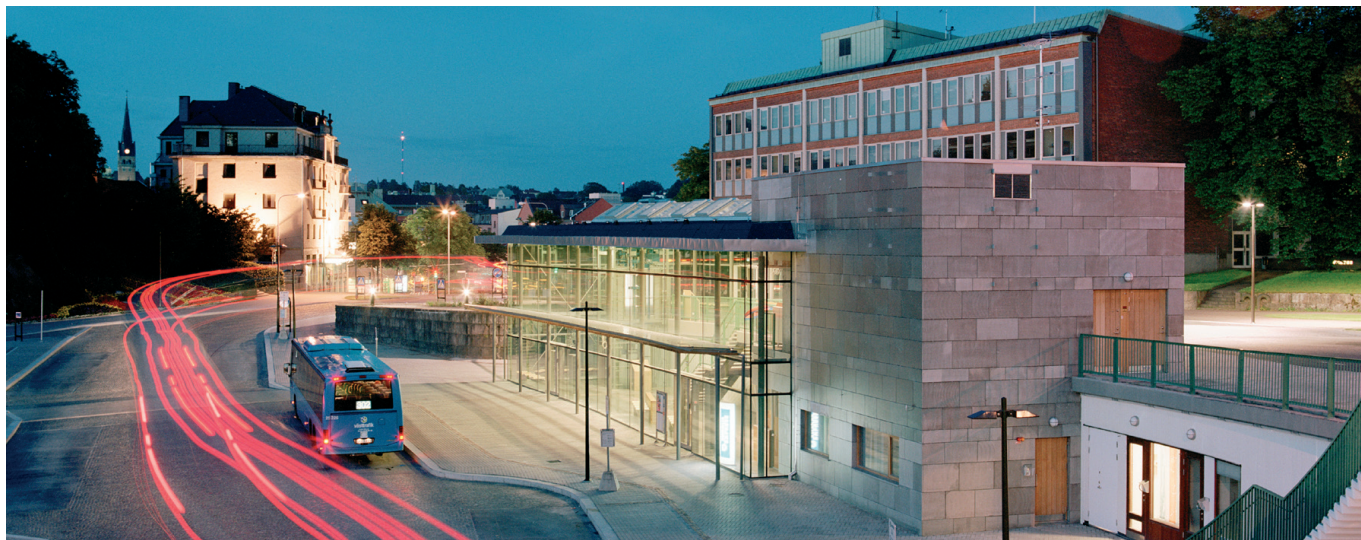
Vänthallens glasade fasad mot norr
