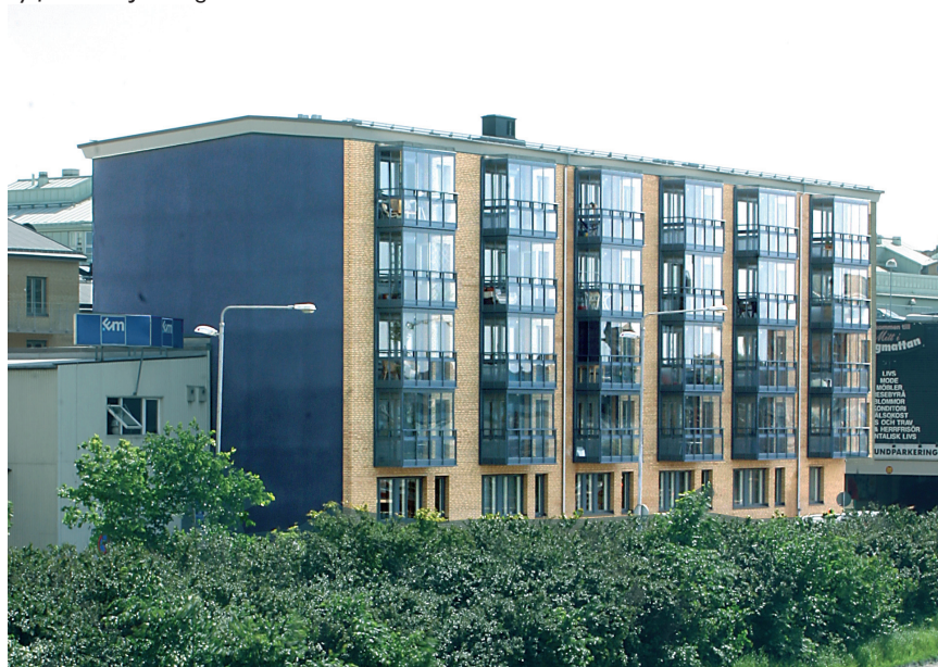
Älvhuset fasad mot nordväst
