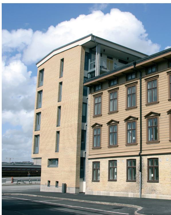
Vy längs Kaptensgatan med mötet mellan det nya Älvhuset och det ombyggda landshövdingehuset
