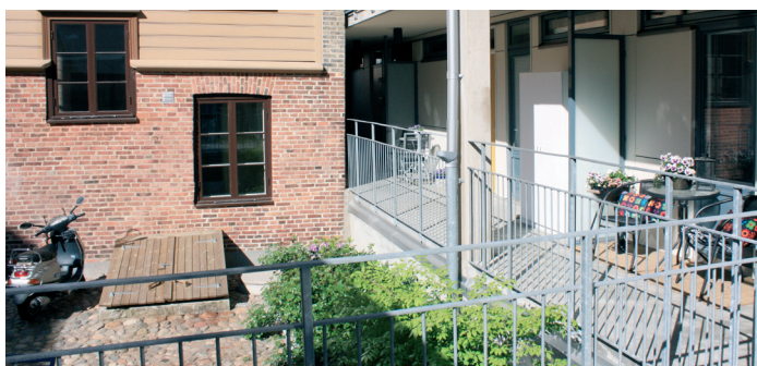
Mötet mellan det ombyggt och nytt
