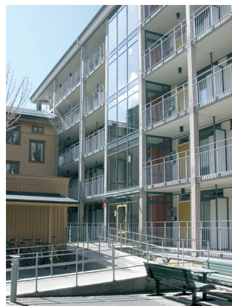
Älvhusets gårdsfasad med loftgångar
