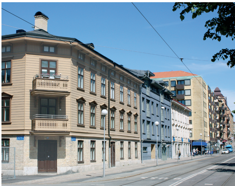
Vy från Karl Johansgatan, det ombyggda huset närmast, det blå huset är nybyggt
