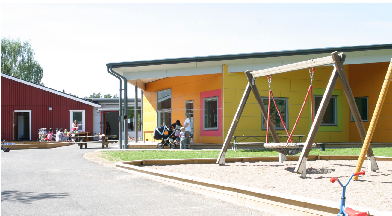
TILLBYGGNADENS FASADER I STARKA KULÖRER
