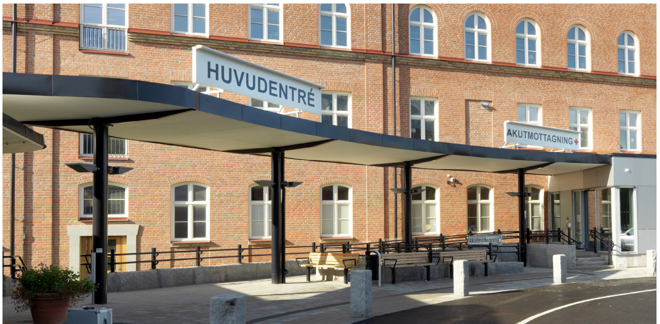
SKÄRMTAKET OCH HUS 9 I BAKGRUNDEN
